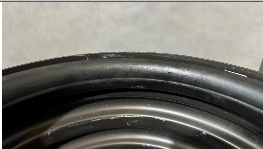
Rys.5 – instalacja uszczelki w najwyższej wewnętrznej dolinie rury (w zależności od rury uszczelka może układać się w różny sposób).
