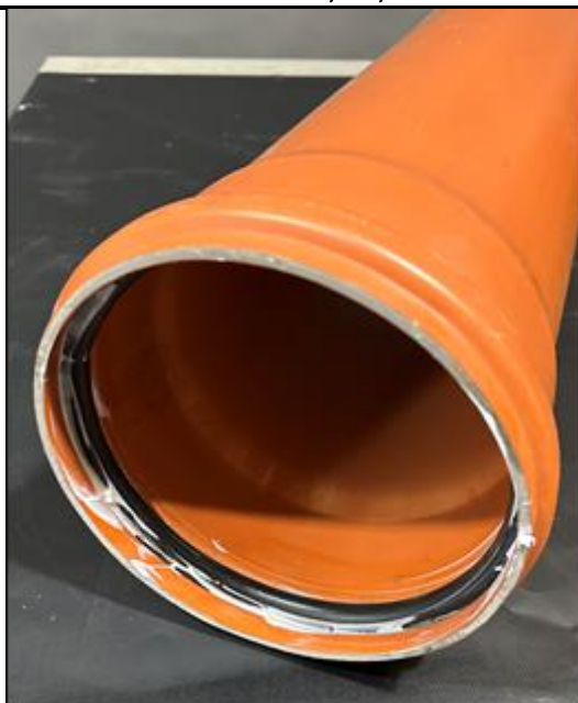
Rys.8 – Aplikacja smaru do łączenia ze sobą gładkich rur tworzywowych dowolnych średnic.
